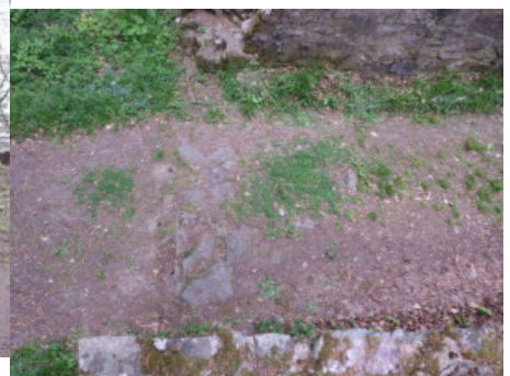
Torschwelle mit originaler Fundamentunterlage von oben
