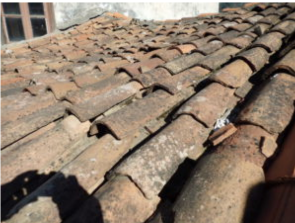
Dach in Mönch-Nonnen-Deckung
