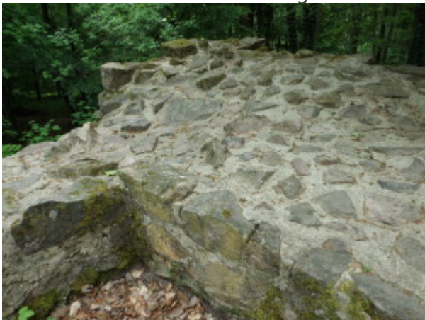
südöstliche 2,70 m starke Ringmauerecke
