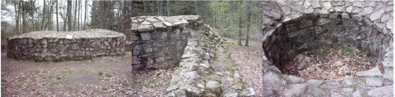
Der 1977 restaurierte Turmstumpf mit seinem originalen Mauervorsprung im unteren Bereich
