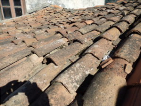
Dach in Mönch-Nonnen-Deckung
