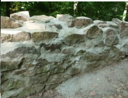
Ringmauerinnenschale aufgesetzt und verfugt
