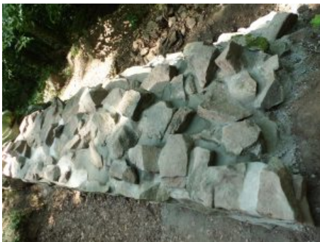
3 m nördliche Ringmauer von oben, der Mauerkern
