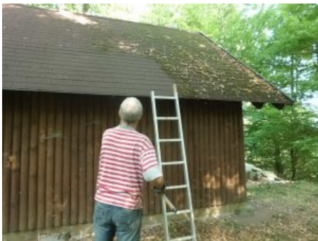
die Hälfte des Daches ist schon geschafft
