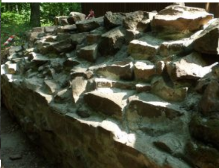
nördliche Ringmaueraußenseite mit abgetrepptem Mauerkern
