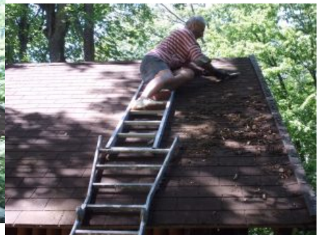
Moosbeseitigung auf dem Dach der Wanderhütte mit 2 Leitern
