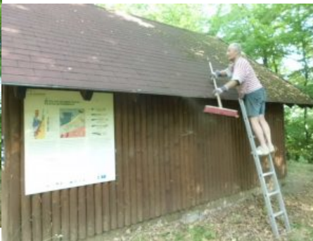
6 Stahlbürsten wurden bei der Moosbekämpfung verbraucht
