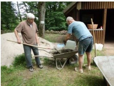
Sand, Trasszement 3:1 und Wasser ergeben den passenden Mörtel, der nicht ausblüht
