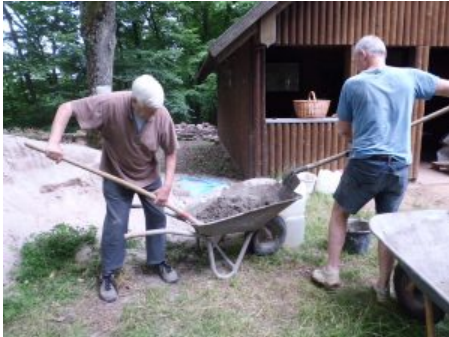
Trasszement und Sand 1:3 in einer Schiebkarre händisch mischen
