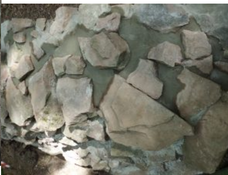
Mauerkern mit Steinen und Trasszementmörtel verfüllt
