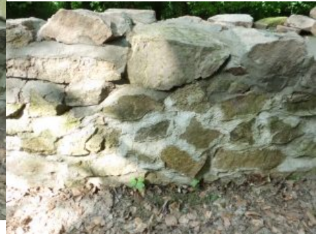
Ringmauer-Innenschale wird mit passenden Steinen aus dem Versturz neu aufgesetzt
