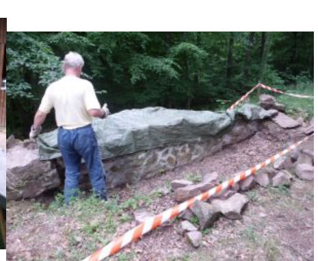
Feierabend, abgedecktes frisches Ringmauerwerk der Ruine Schnellerts
