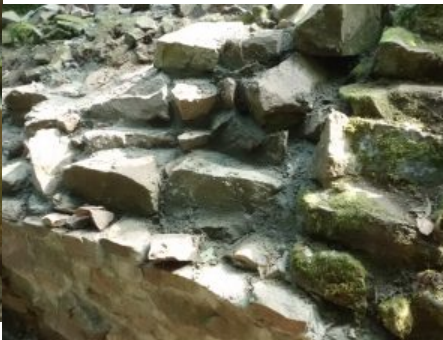
stufenförmige Verfüllung des Mauerinnenkerns
