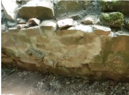
Ringmauer-Außenschale mit Trasszement neu verfugt
