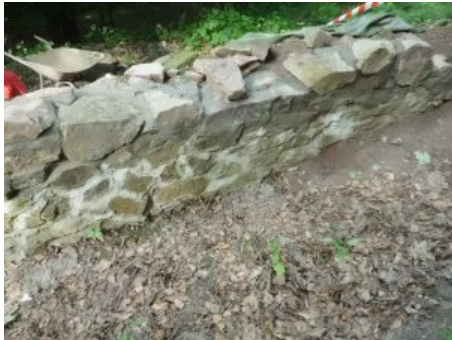
nördliche Ringmauer- Innenschale mit aufgesetzten Bruchsteinen mit Gesicht
