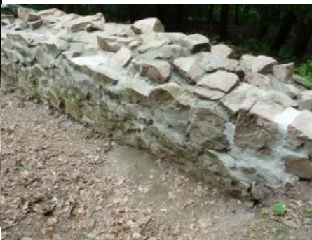
nördliche Ringmauer mit verfülltem Mauerkern
