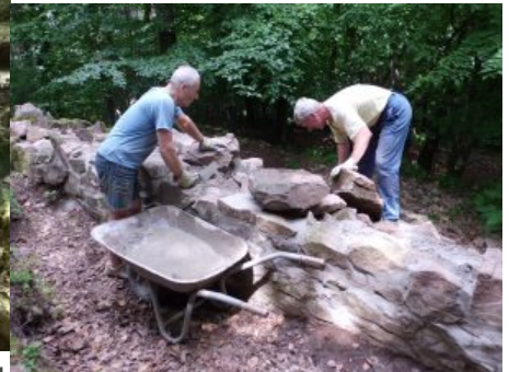
Mauerkern mit großen Steinen verfüllen
