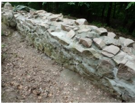
2018 restaurierte nördliche Ringmauerinnenseite
