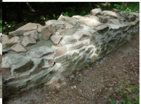
2018 frisch verfüllter Mauerkern der nördlichen Ringmauer
