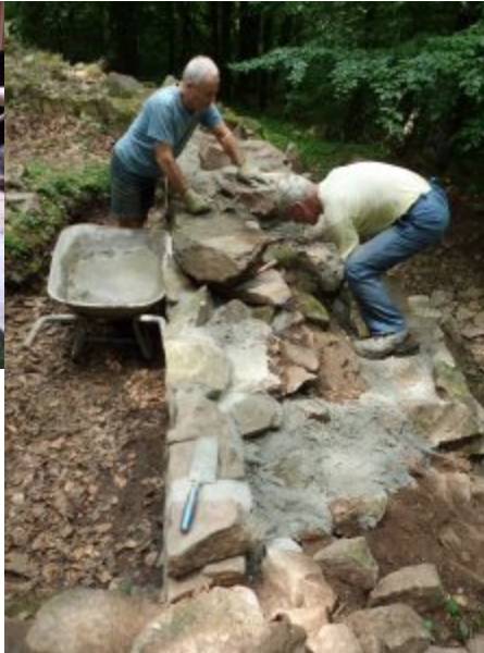
Ringmauerkrone mit Zementmörtel und Bruchsteinen schließen
