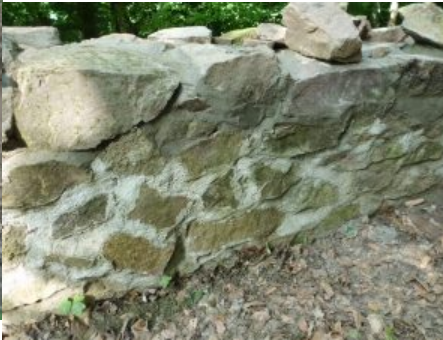
nördliche neu verfugte Ringmauer-Innenseite
