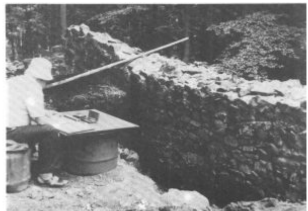
Aufmaß der 1984 freigelegten inneren Schalmauer
