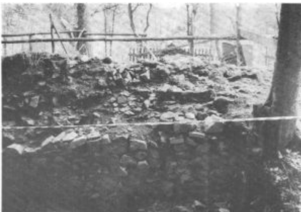
Teilansicht der 1979 von Mauerversturz und Bewuchs gesäuberten Ringmauer (äußere Schalmauer im N/W-Bereich)
