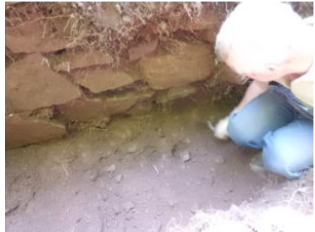
Fundamentvorsprung auf der nördlichen Ringmaueraußenseite
