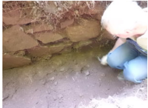
Fundamentvorsprung auf der nördlichen Ringmaueraußenseite
